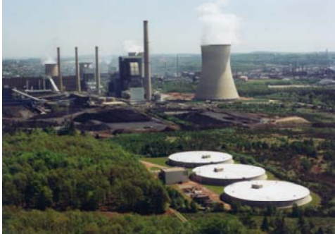
Ci-dessus : centrale thermique Ci-contre : détail d'une cimenterie
