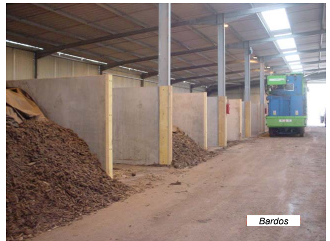
Biarritz Bardos (Usine de compostage) Compostage en casiers
